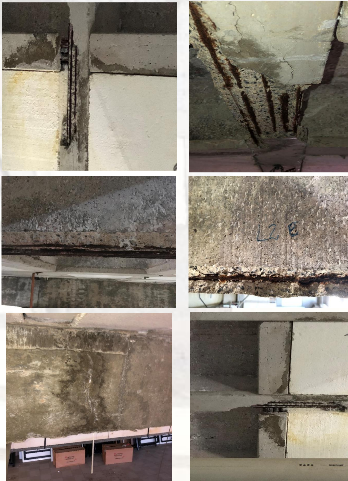
Figura 23 – Imagens de pontos de desprendimentos do concreto e infiltração nas lajes do auditório.
