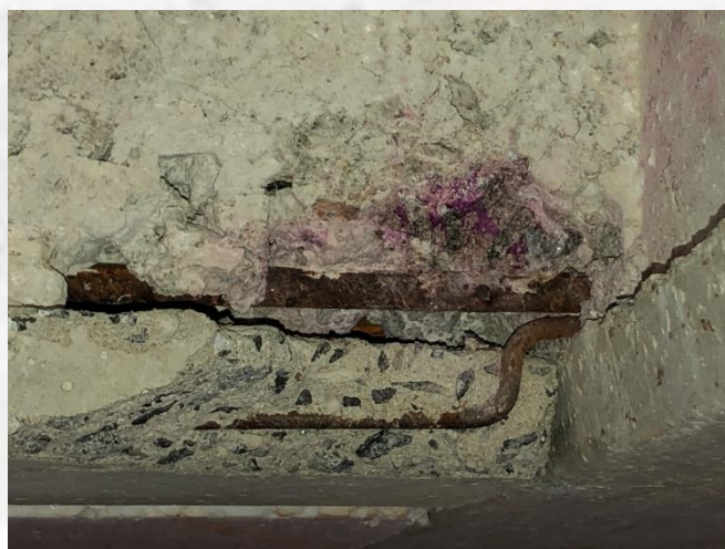
Figura 29 – Descolamento na interface entre o concreto pré-fabricado e o concreto moldado in loco .
