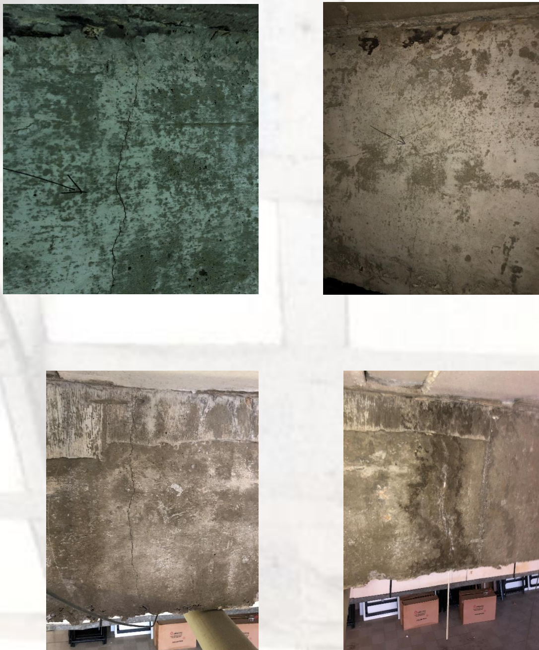
Figura 24 – Fissuras em lajes e vigas nas áreas do auditório e escada.
